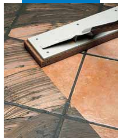
Очистка пола, облицованного плиткой одинарного обжига, при помощи ракли с губкой
