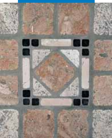
Примр шпаклки искусственно состаренного пологового покрытия из природного камня
