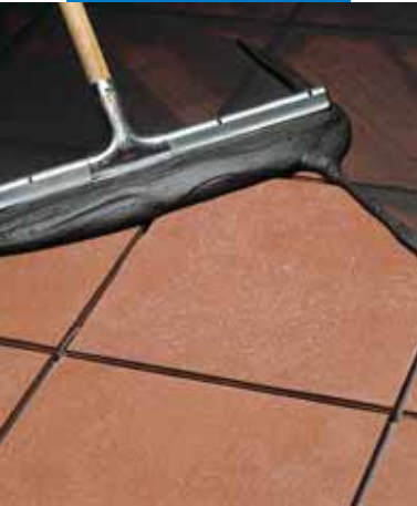
Заполнение швов в полах, облицованных терракотовой плиткой, при помощи ракля
