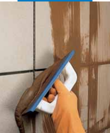
Затирка швов шпателем снаружи помещений
