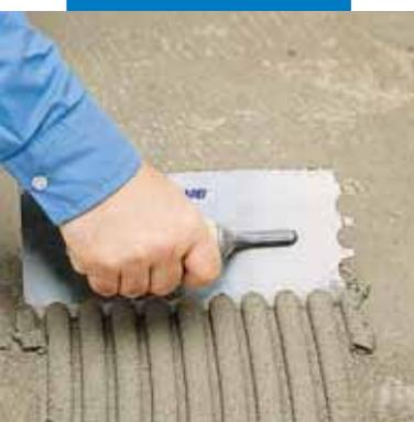
Нанесение клея шпателем с закругленными зубцами
