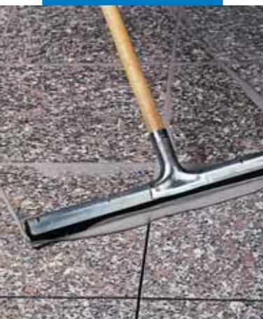
Шпаклевка полового покрытия из полированного гранита скребком
